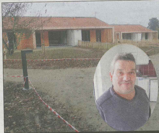
Chaque appartement s'ouvre sur un cadre de verdure très proche par liaison douce des services de la commune. En médaillon, Patrice Pinel dans son nouvel appartement.
